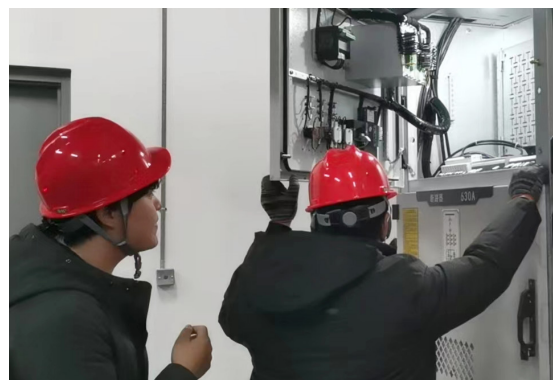
安全设施检查
