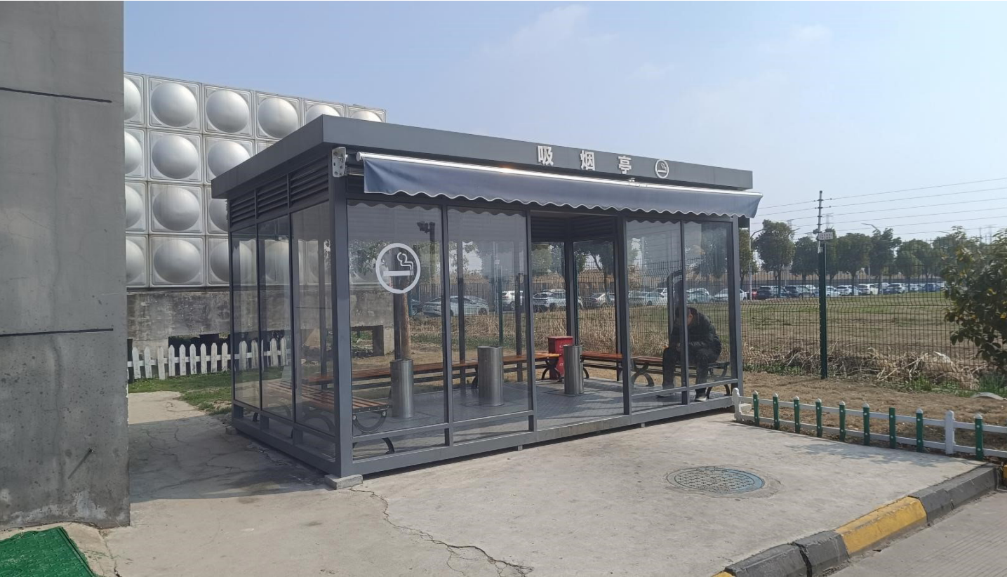
东久（昆山）智造园室外吸烟亭
