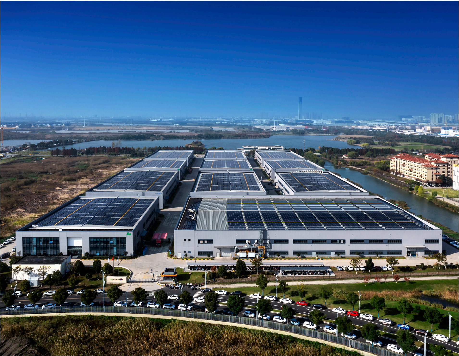
东久（昆山）智造园屋顶铺设的光伏
